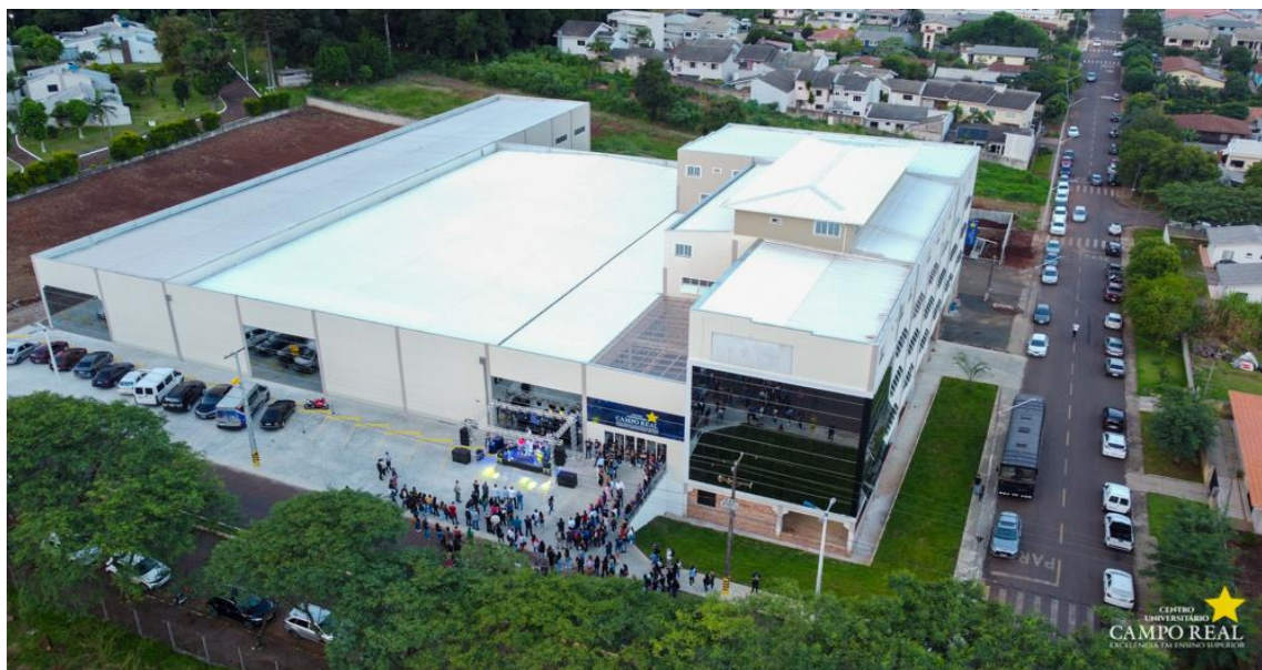
Figura 8 – Vista da Estrutura do Campus Laranjeiras do Sul Rua Santana
